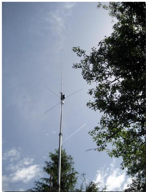
Seit 6 Jahren verwende ich eine unabgespannte Cushcraft R7000 auf einem 12,5m-Kurbelmast an meinem Zweitwohnsitz in Steinbach a.d.Steyr in 700m Seehöhe. Die Windverhältnisse können sehr extrem sein, sodass die Antenne nach Aktivitätssende auf 4m Höhe eingekurbelt wird.
