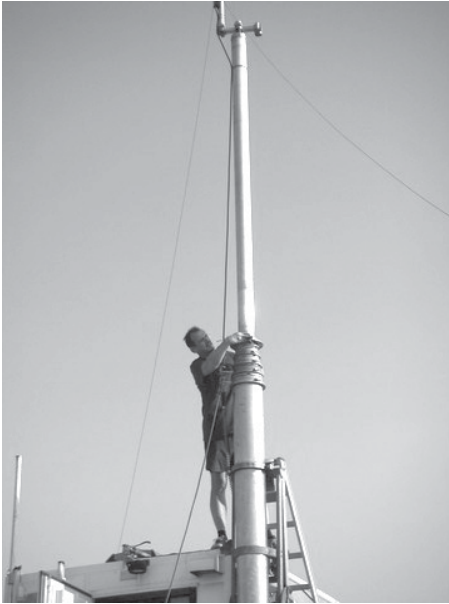
OE3GCU bei der Antennenmontage.
