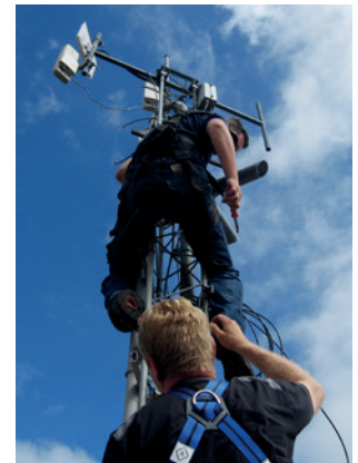
rechts: Montage der Antenne Diamond X30
