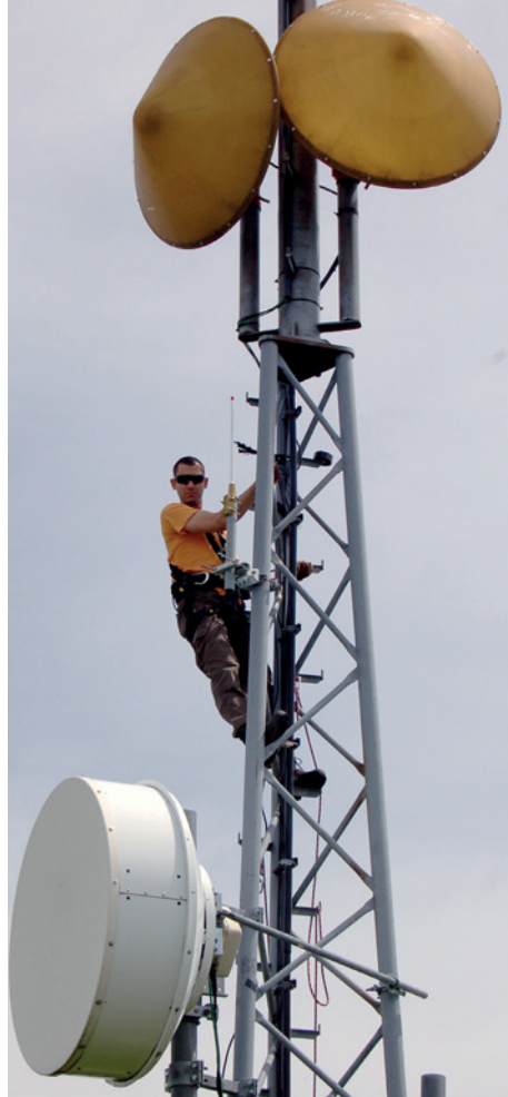
OE1SGW bei der Antennen-Montage
