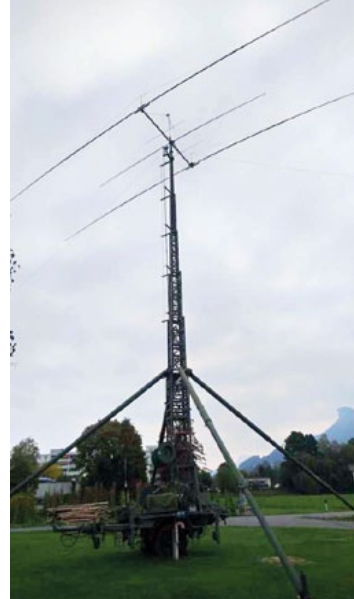
die Antennenanlage OE9R
