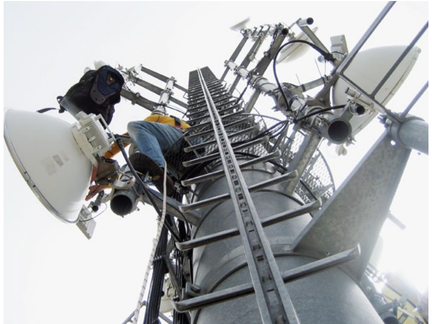
oben: OE8WUR beim umpositionieren der Antenne Richtung Magdalensberg
