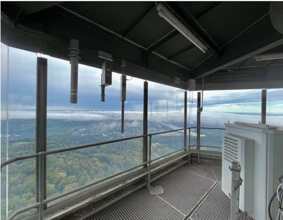
Frequenzbaken dienen einerseits als Signalquellen, um die Betriebstüchtigkeit des eigenen Empfängers und der eigenen Antennenanlage zu überprüfen, andererseits sind sie eine wichtige Signalquelle bei Empfang von troposphärischen Überreichweiten und zum Aufspüren von Regenwellen für Mikrowellenstreuverbindungen („rain scatter propagation“). Frequenzbaken sind weltweit auf allen dem Amateurfunk zugewiesenen Frequenzbereichen mit unterschiedlichsten Modulationsarten in Betrieb.
