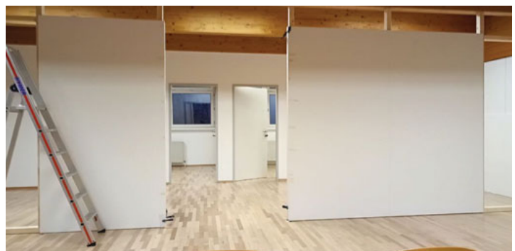
Einbau der Trennwand für Lager/Werkstatt am 21.11.2024 Foto: Viktor OE9VLV
