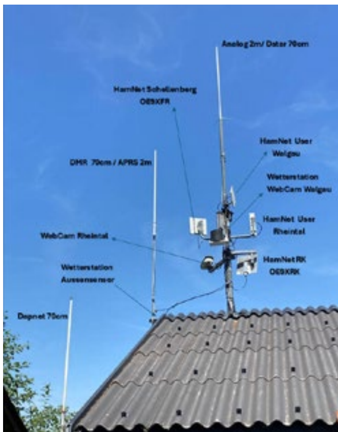
rechts die Antennen-Komponenten von OE9XVI; Quelle: qrz.com
